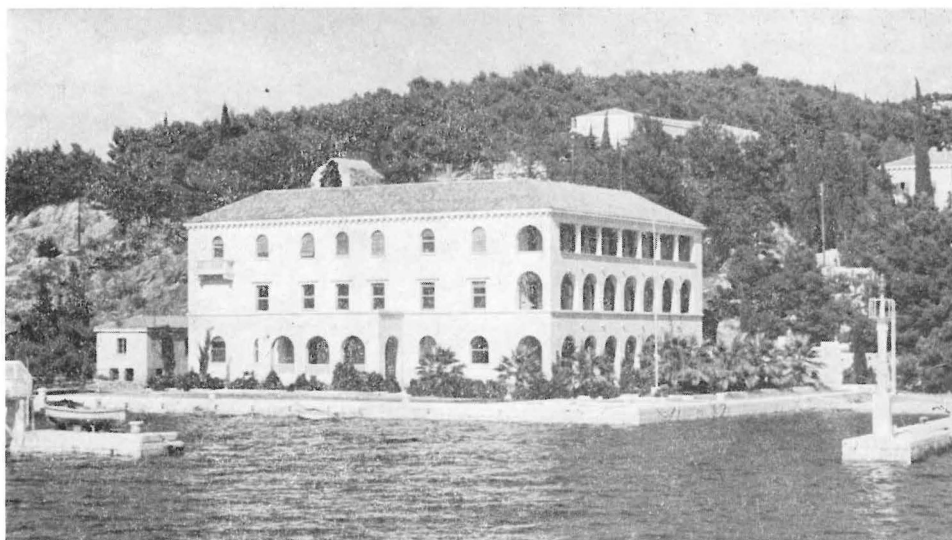
Glavna zgrada Instituta Institute center
